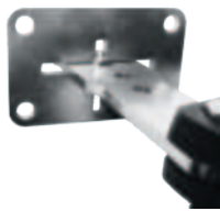
Montaż blachy na szerokim słupku
