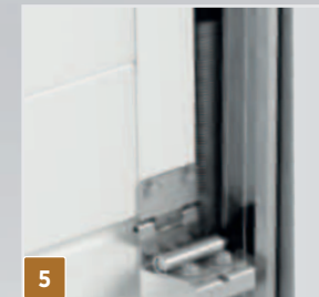
Układ sprężyn naciągowych
