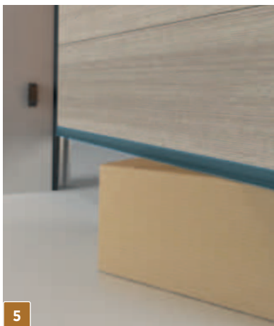
Zabezpieczenie przeciążeniowe w bramie automatycznej
