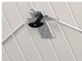
Zamek z wkładką ryglującą bramę dwustronnie
